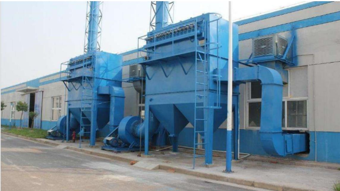
袋式除尘器的应用已有百余年的历史，其比较大的优点是除尘效率高（达99.99%以上），排放浓度可达到 $10\text{mg}/\text{m}^3$ 以下，且分级效率也很高，对 $2.5\mu\text{m}$ 以下的微细颗粒物也有很好的捕集效率，因此得到的应用。但袋式除尘器经过多年的运行也暴露出一些问题，如滤袋易损坏、结露、运行阻力高、清灰失灵、灰斗卸灰不畅等。造成袋式除尘器运行出现问题的因素有很多，除了除尘器自身因素外，操作、管理不当也是造成其在运行中出现问题的重要原因。本文对目前袋式除尘器在运行过程中经常出现的问题进行了分析讨论。蓝田环保除尘设备价格除尘设备目前已应用于我国电力、水利、钢铁、化工等行业。
